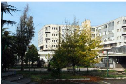
Sede centrale Via Nicola Calandra BENEVENTO
